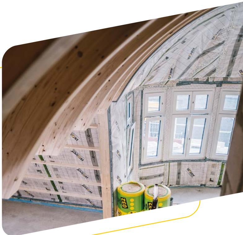
Die aufwendige Dachkonstruktion aus polygonaler Kuppel und Schrägdachflächen wurde mit einer 240 mm starken Zwischensparrendämmung und 60 mm starken Untersparrendämmung aus ISOVER Glaswolle gedämmt.
