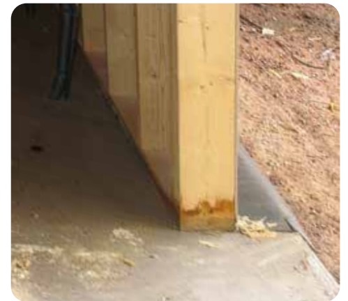
Vattenskada på syll och väggregel syns tydligt som missfärgning
